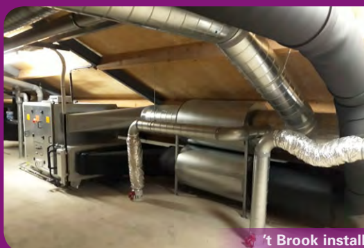
't Brook installatie topkoeling
