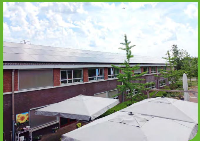
^ Zonnepanelen op het dak van zorgcentrum 't Brook
